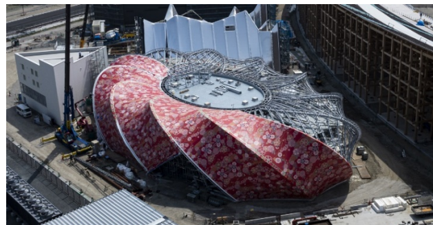
鳥瞰写真(西陣織膜と鉄骨骨組)
